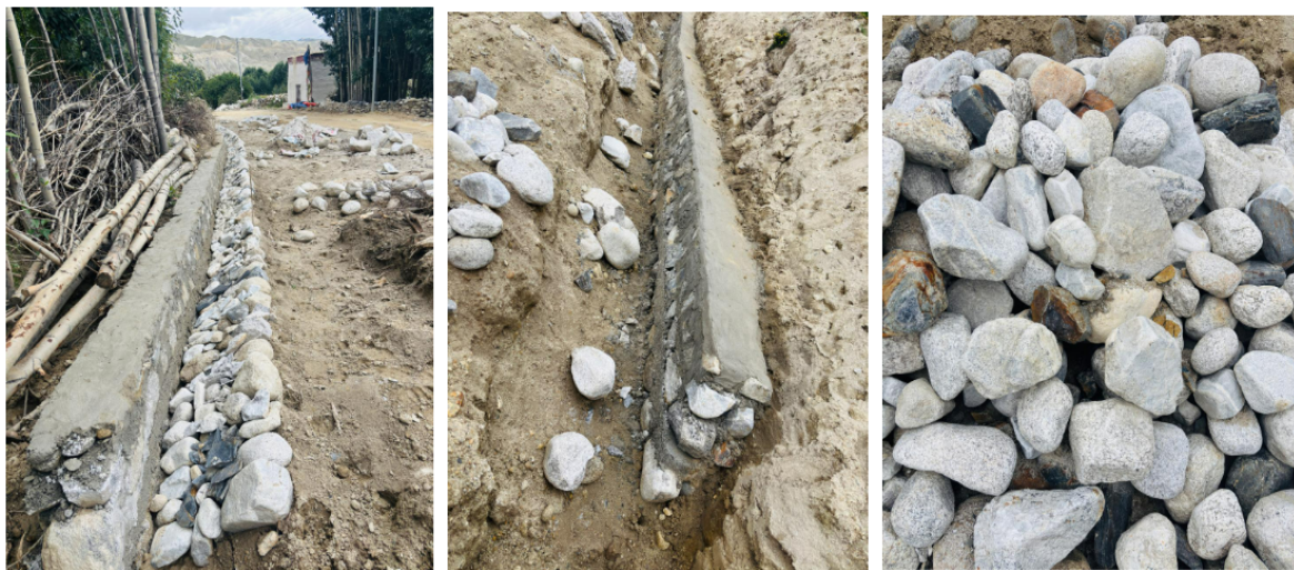
निर्माणाधीन नेचुड चक्रपथ र त्यसमा प्रयोग भएका निर्माण सामग्री।
